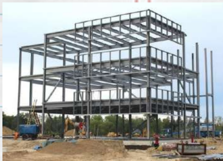
Pekerjaan Konstruksi Baja
